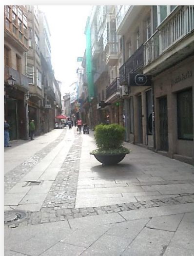
IMAGEN XXVII: Calle del “Arrabal” (“Comercio”) que enlazaba la plaza del “Azogue” (Plaza de España) con la plaza de los Herradores (Puente Principal). Setiembre 2018.
