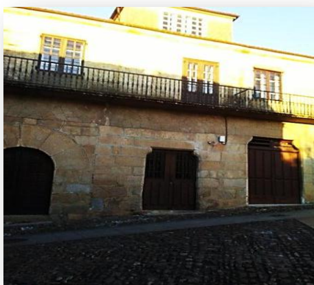
IMAGEN XXVIII: Vista parcial fachada de la casa de los “Gaibor” en la “Falageueira” (Puerta “Pescaderías”). Setiembre 2018
