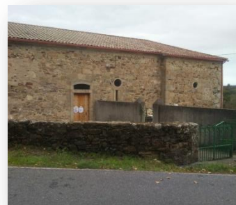
IMAGEN X: Lateral iglesia de A Vide y muro cierre cementerio. (Enero 2020)
