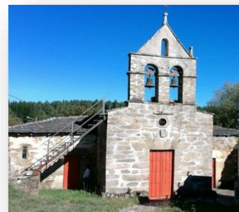
IMAGEN X: Fachada iglesia Rozavales. (Setiembre 2017)
